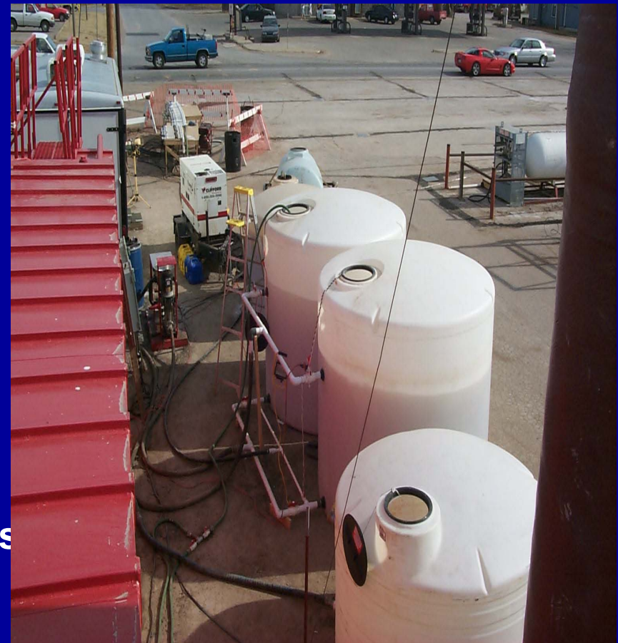
Bixby UST Site
